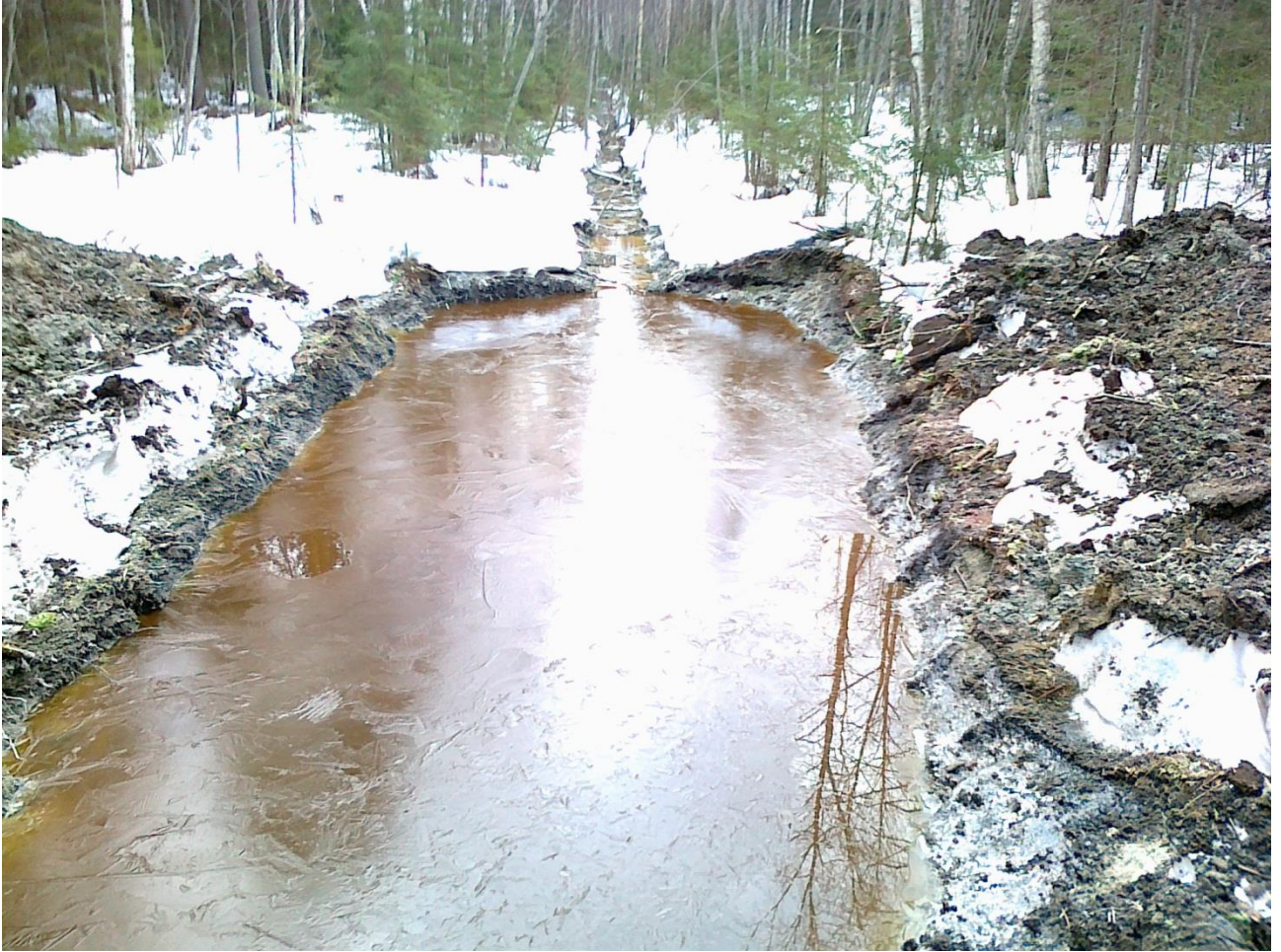
Kuva 2. Laskeutusaltaan muoto on syytä olla pitkänomainen, jotta kiintoainepartikkeli ehtii laskeutua altaan pohjalle.
